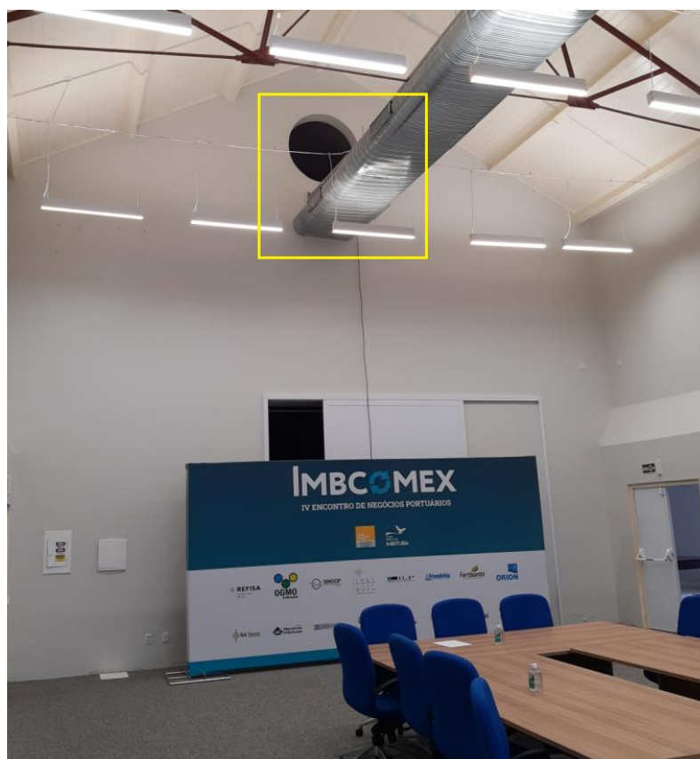
Figura 4 – Local de Instalação da estrutura metálica.
